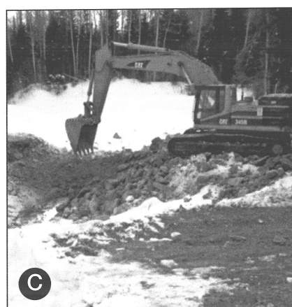
Figure 8 - Photos des différentes étapes des travaux d'enrochement du cours d'eau Bonhomme-Morency : nettoyage du lit et des berges (A), couche de tout-venant (B), excavation du lit (C) et couche de protection (D). Source : Tescult, 2009.
