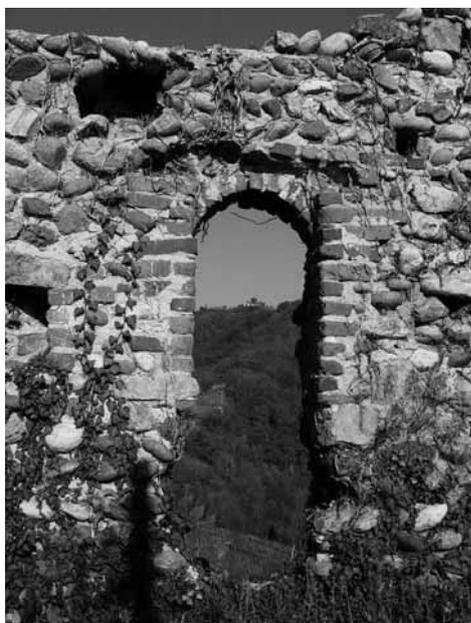
Fig. 5b – Gattinara, Le Castelle. Tratto di muro del recinto settentrionale, prospetto interno. In evidenza l’apertura incassata in laterizio; sullo sfondo l’altura con il castello di S. Lorenzo (foto dell’Autrice).
