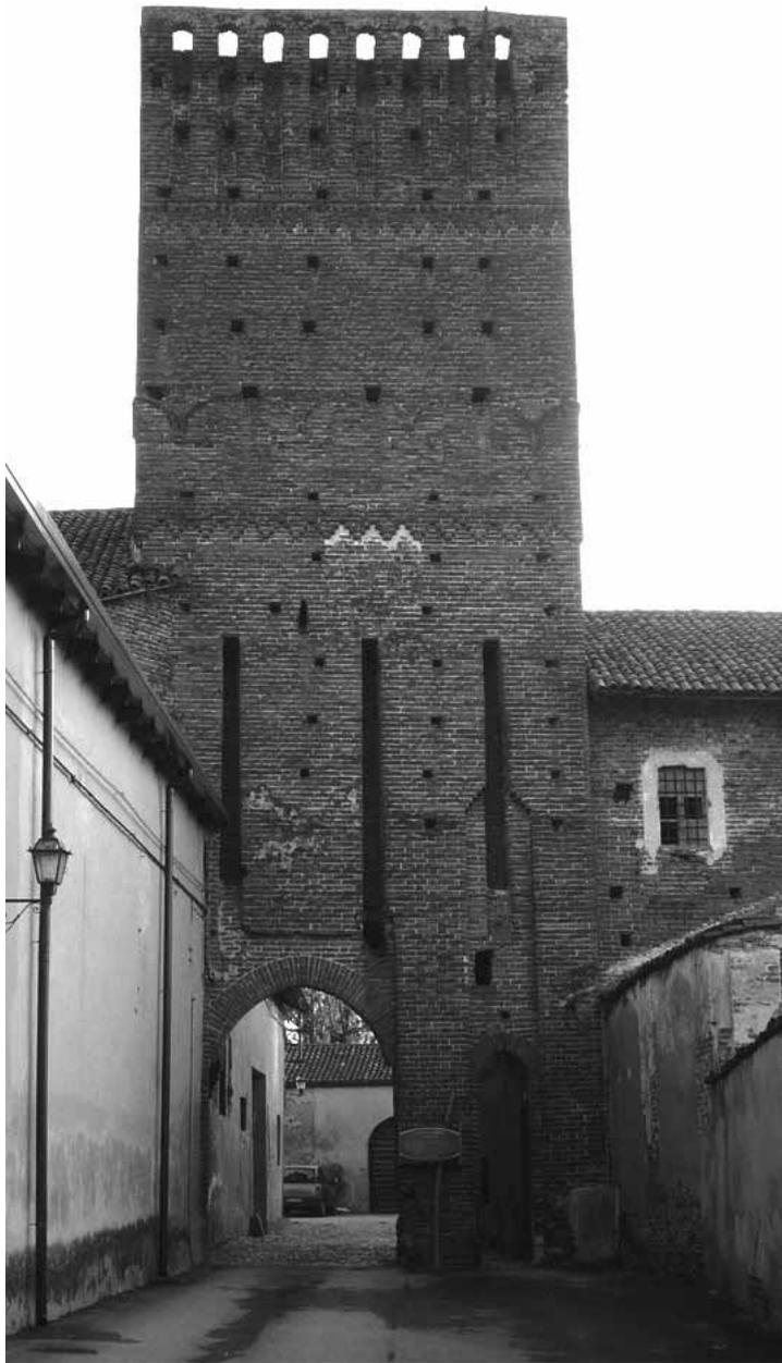
Fig. 9 – Collobiano. Torre-porta. Al di sopra del fregio a dentelli scalari si osservano i merli, inglobati nella muratura soprastante (foto dell'Autrice).
