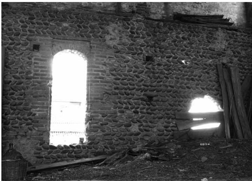
Fig. 4b – Gattinara. Tratto di fortificazione in un isolato prospettante su via Lamarmora, lato interno. Sulla sinistra si osserva l'apertura incassata in laterizio (foto dell'Autrice).
