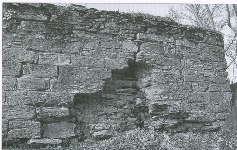
Fig. 7 – Particolare della muratura del lato est del palatium.
