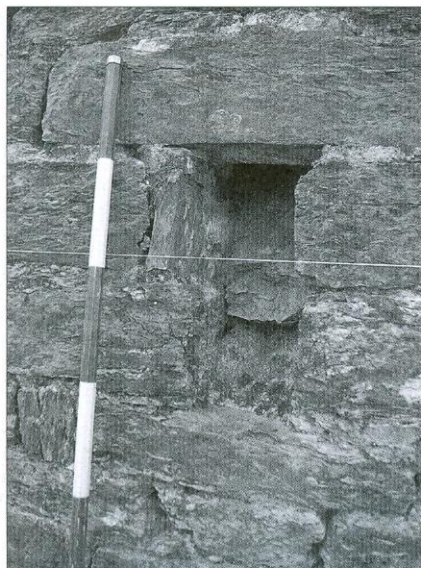
Fig. 10 – Lato ovest particolare di una feritoia per lo scolo delle acque.
