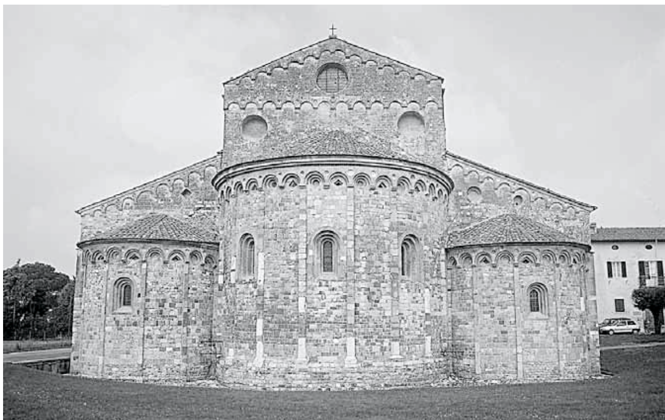
Fig. 2 – Facciata di San Pietro a Grado (fine X-inizi XI). È uno degli edifici più antichi dell'Italia centro-settentrionale realizzato in età medievale con l'opera quadrata.
