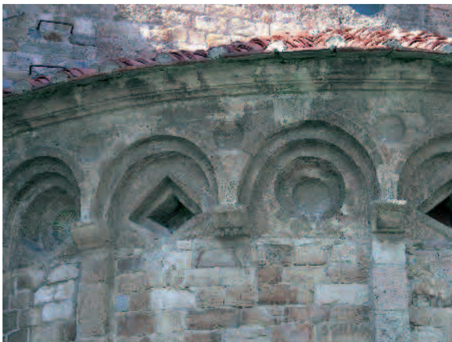
Figura 8. Detalle de las técnicas constructivas empleadas en los ábsides orientales de la iglesia de San Piero a Grado (Pisa)
