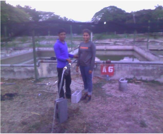
Anexo 3. Instalación del sistema de riego por goteo, granja de cultivo de peces UNA, Managua 2016
