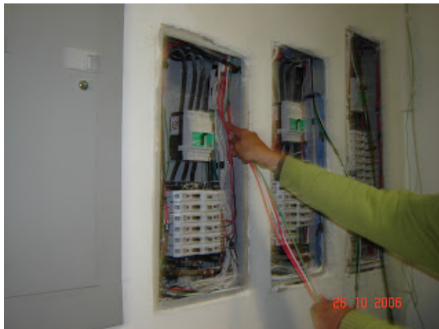
Construcción de sistema eléctrico de la sala
