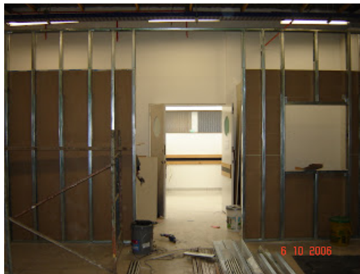
Iniciando los muros en GYPLAC
