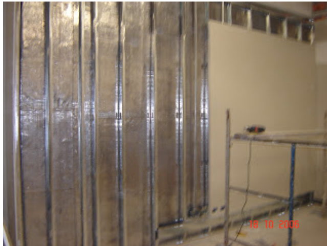
Proceso de colocación de plomo recubrimiento de plomo con muro en GYPLAC
