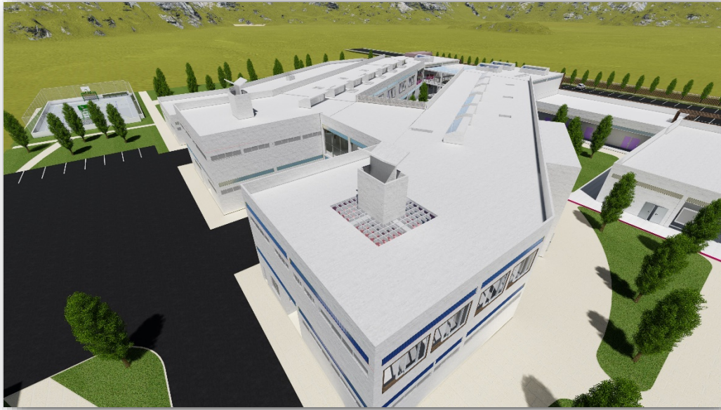
Figura n° 49: Vista de diversas estrategias bioclimáticas: Torre viento, efectos chimenea, rejillas de captación de vientos, patios, ventanas de láminas de control solar.
