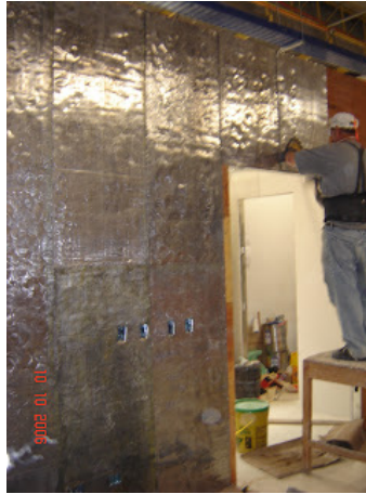
Proceso de colocación de plomo recubrimiento de plomo con muro en GYPLAC
