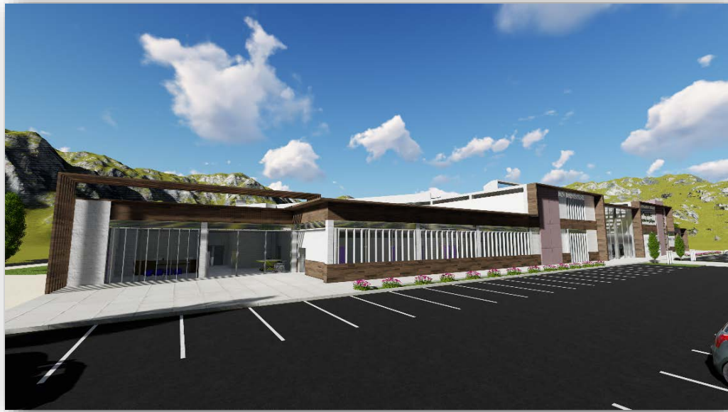
Figura n° 43: Vista de ingreso a urgencias e ingreso principal, elementos de control solar verticales
