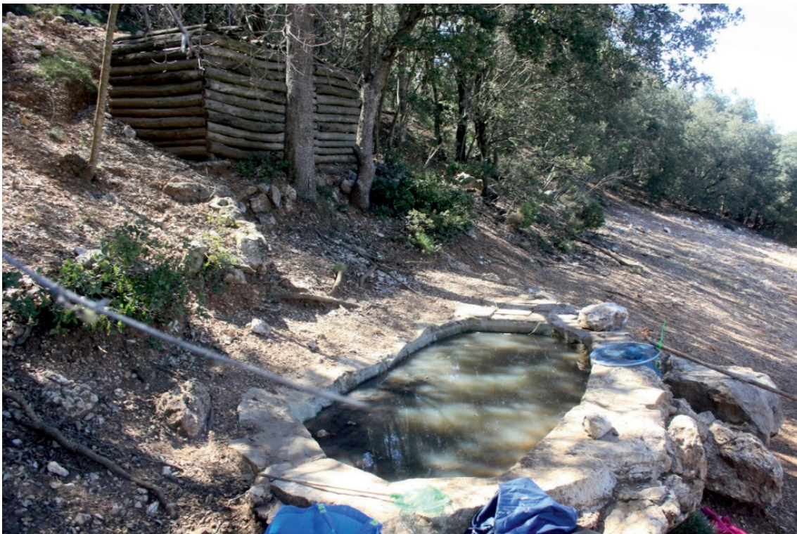
Ilustración 2. Abrevadero del bancal del Carrascal, al fondo el depósito del abrevadero. Foto propia.
