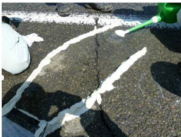
写真-3.4 舗装路面のクラックへの浸透量調査状況 9)
