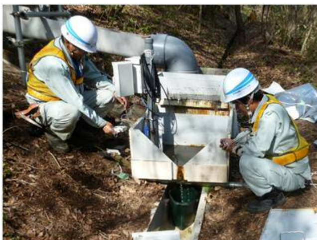
写真-3.5 散水試験による排水路への流出量調査 9)
