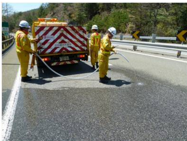
写真-3.3 散水試験による路面散水状況 9)
