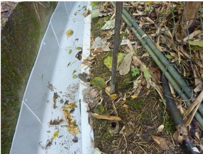
写真-7.2 FRPを使用した水路目地補修対策
