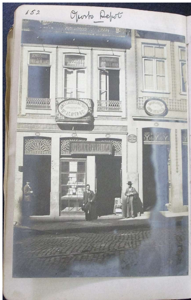
19 – Imagem do exterior do Depósito da SBBE na cidade do Porto. A fotografia não está datada mas tendo em conta o letreiro “Livraria Evangélica”, identificado noutras fontes da SBBE, será o da Rua Mouzinho da Silveira, n.º 89. [s/d]. In Dr. Ritson’s Black Books. Portugal to 1913. Notebook - BSA/D2/14/6 – BFBS Archives – Cambridge University Library
