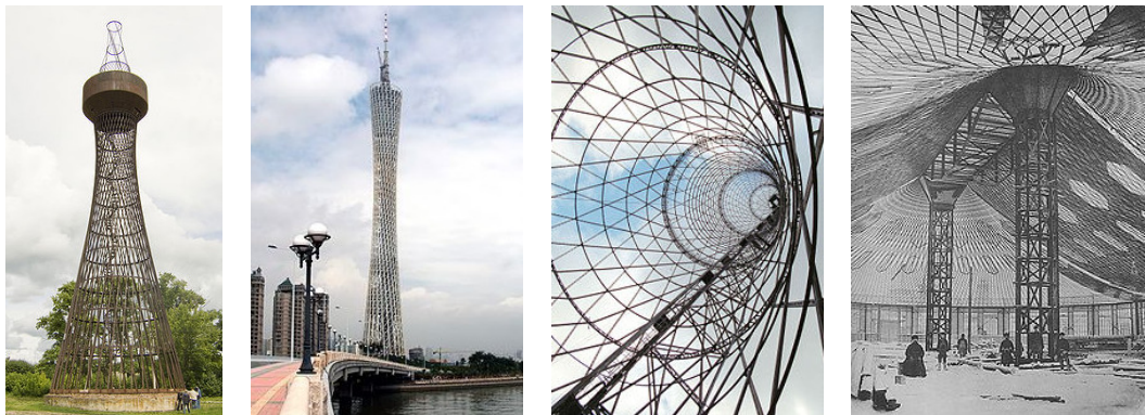
Рисунок 3.50 – Споруди, побудовані за методом В. Г. Шухова
