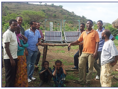
Instalación de un sistema de energía fotovoltaica en la escuela de Ebrah (Etiopía, 2014)
