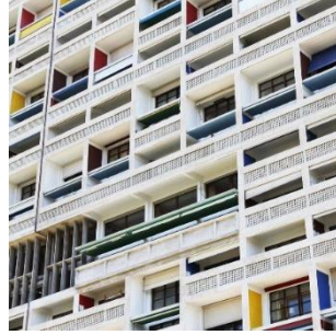
Figura 36 - Imagem de uma das fachadas, mostrando as loggias e a sua policromia
