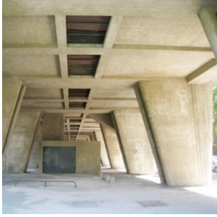
Figura 35 - Vista por baixo do edifício, ao nível da cota da rua, mostrando os pilotis que o suportam
