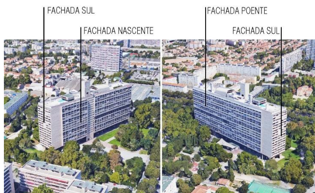
Figura 30 - Vistas aéreas: à esquerda, fachadas Sul e Nascente; à direita, fachadas Sul e Poente
