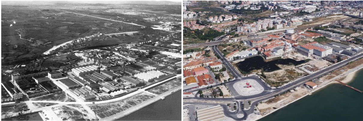
Figura 6 - Área de intervenção: antes e depois
