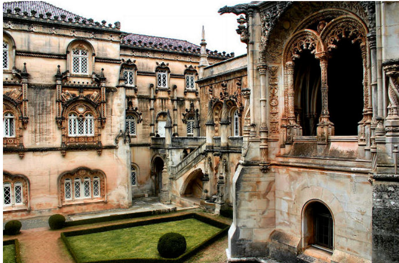
Figura 62 - Palace-Hotel do Buçaco. Vista exterior do pátio-jardim.
