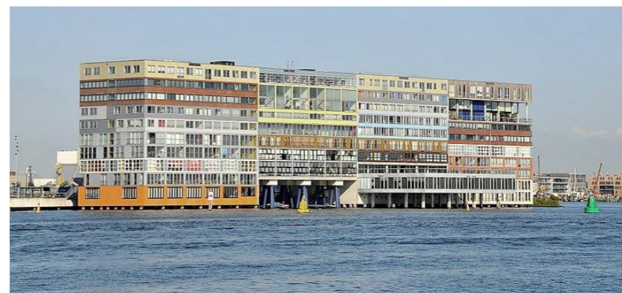
Imagem 18: Edifício Silodam Amesterdão, Holanda 1995-2003
