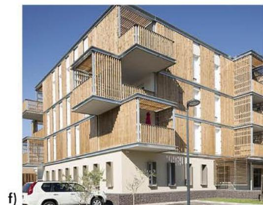
Figura 89 – Fachada Habitável Fixa com elementos de ensombramento/proteção 2ª pele vãos
