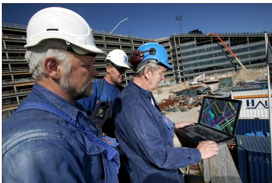
Fig. 9: Foto der viser anvendelsen af bygningsmodellerne på byggepladsen, hvor gratis viewere giver muligheder for at granske modellerne for at afklare tvivlspørgsmål for konstruktioner.
