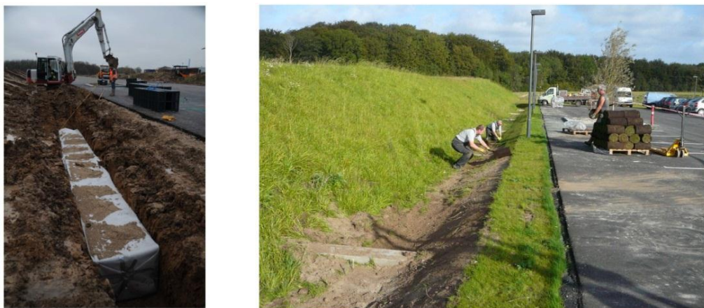
Figur 4 Etablering af filterjord-anlæg til nedsivning og rensning af regnvand (Ingvertsen, 2012)
