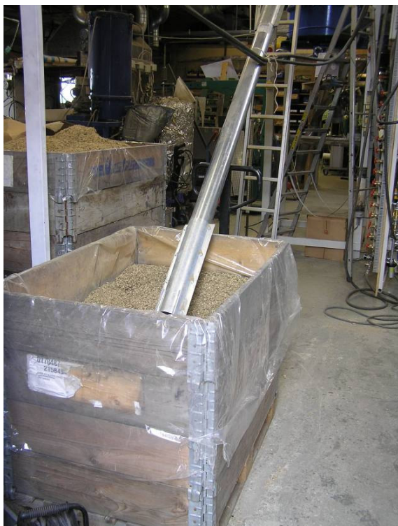
Figur 6: Påslag til genopfyldning af brændselssilo
