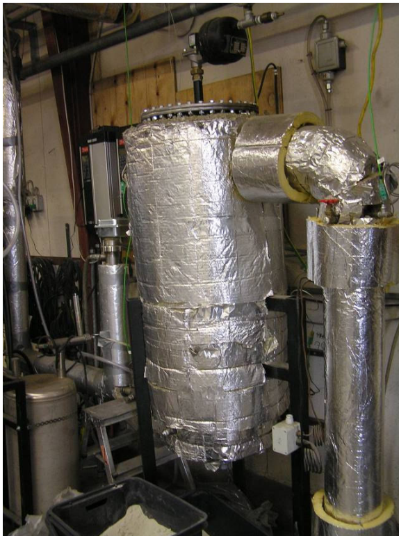
Figur 7: Delstrøms posefilter tilsluttet 100 kW LT-CFB anlægget på DTU.
