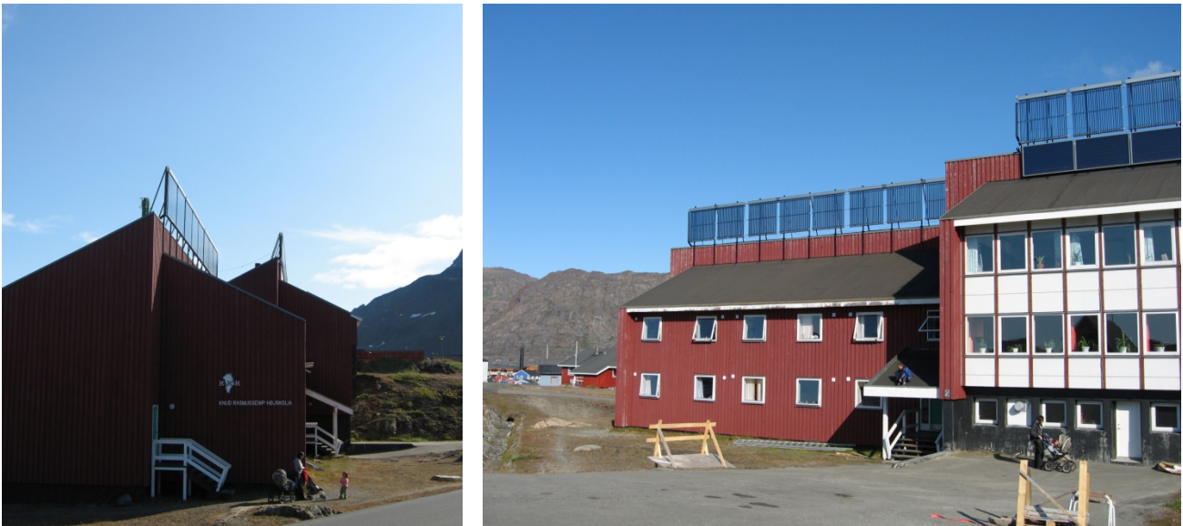
Figur 10 Solvarmeanlæg på Knud Rasmussen Højskolen i Sisimiut.
