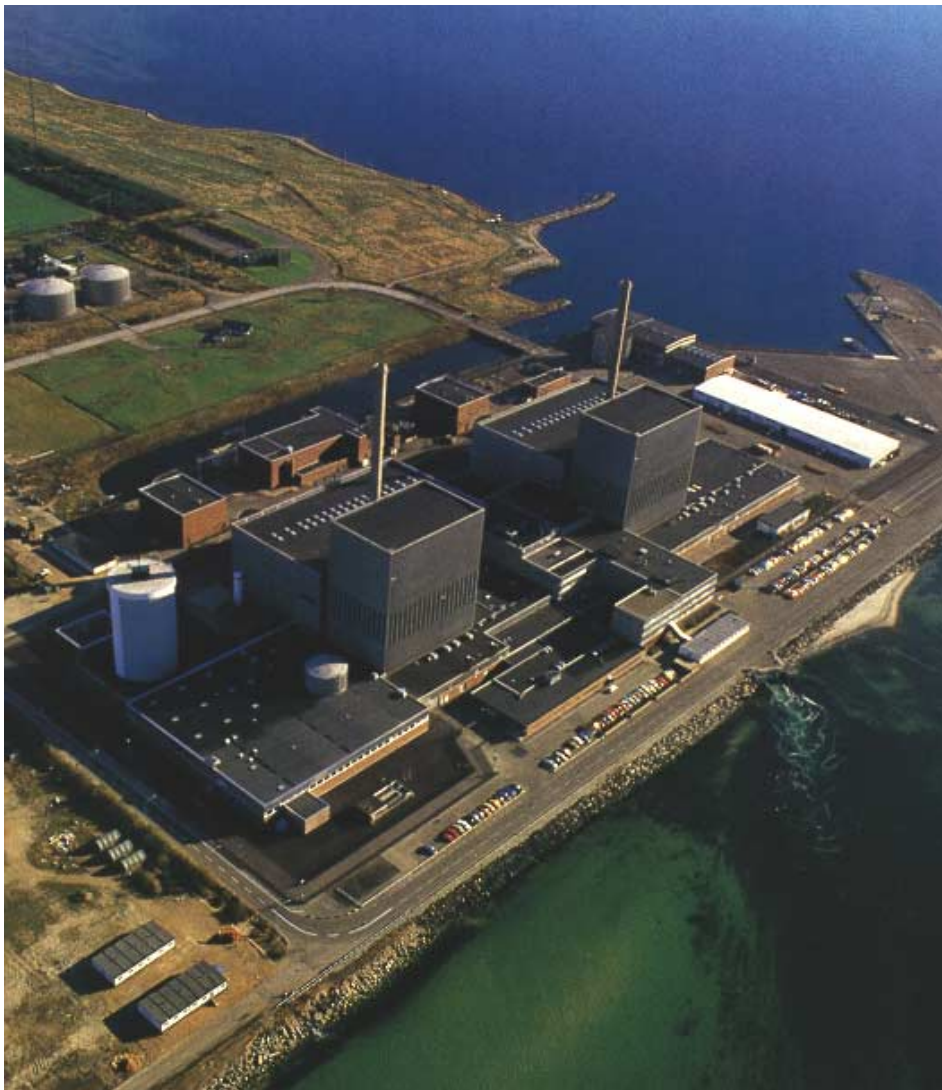
Figur 2.1. Barsebäck-værkets 2 enheder med den nedlukkede Barsebäck 1 til højre i billedet nærmest havneindløbet.
