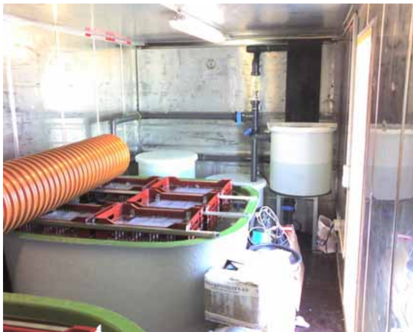
Fig. nr.3.6. Indpumpningsanlæg i container under montage.
