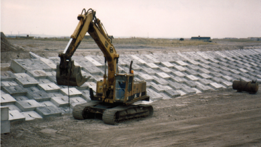
Figur 2.4. Skråningsbeskyttelse med betonblokke.
