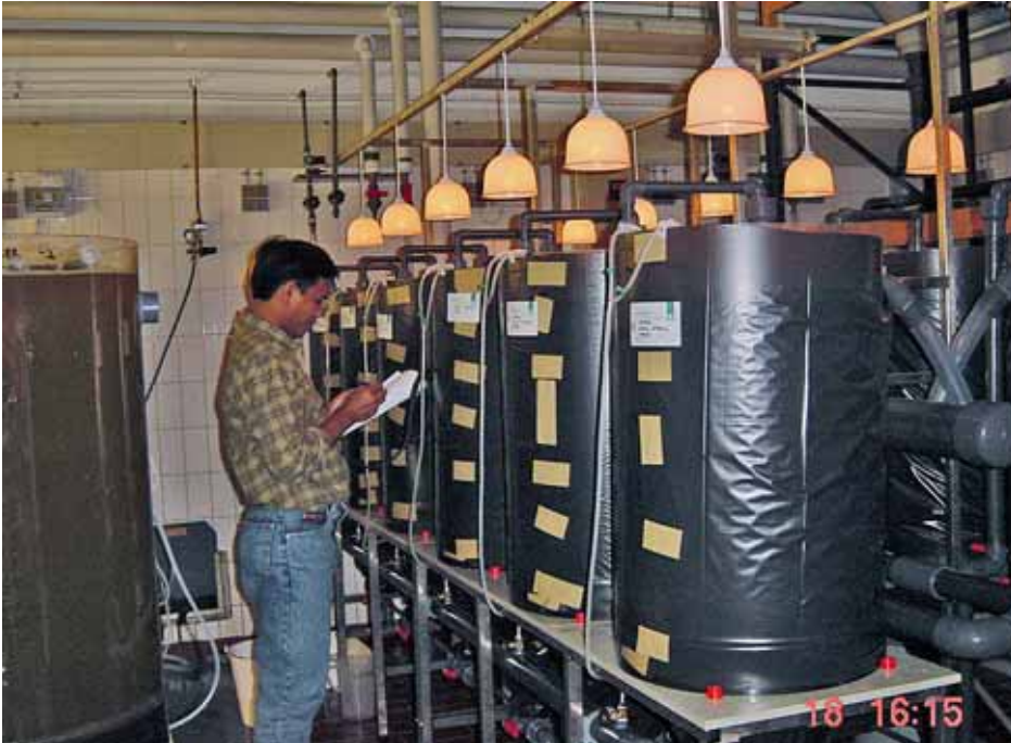
Figur 7. Forsøgsanlægget ved DTU Aqua i Hirtshals hvor forsøget blev gennemført.
