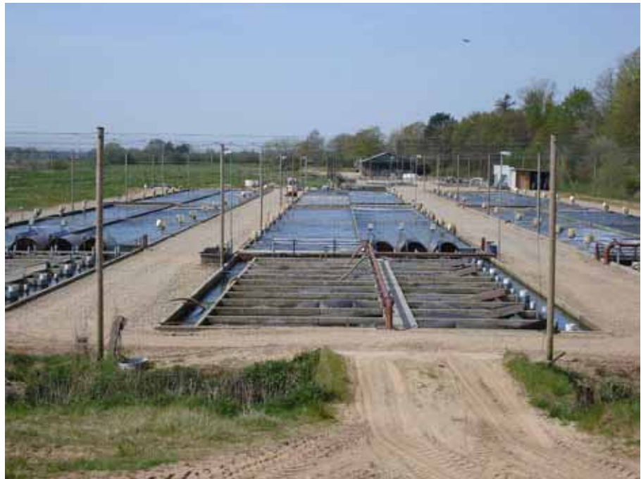
Figur 3.1 Kongeåens Dambrug, De 3 sektionsopdelte produktionsenheder som hver består af 2 lange raceways i beton nu med mikrosigter opstrøms de sektionsopdelte biofiltre, som ses i forgrunden. I baggrunden til venstre ses en del af plantelagunen, som består af plantefyldte tidligere jorddamme og føde- og bagkanaler.
