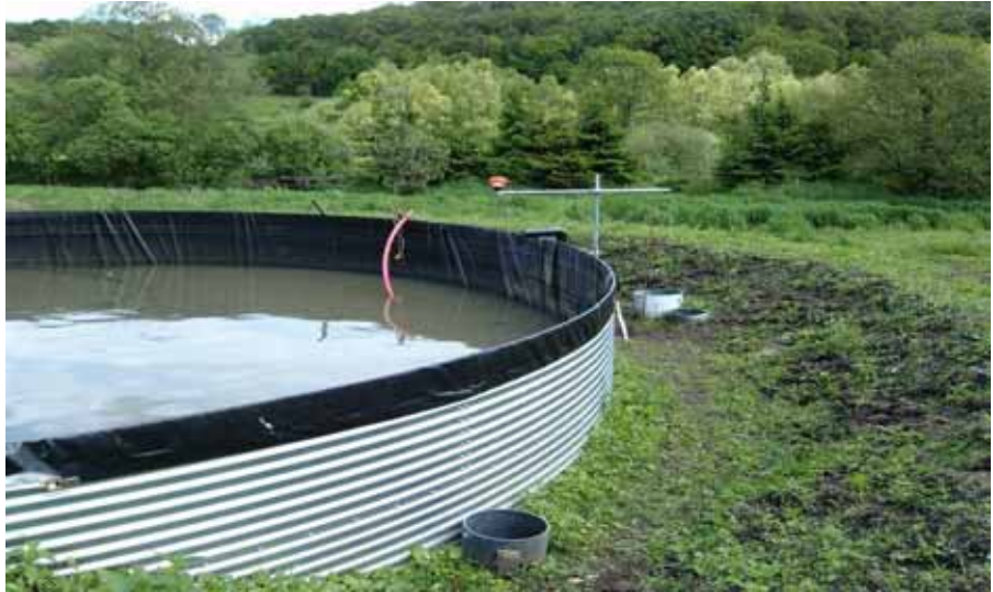
Figur 4.4 Slamtank (gyllebeholder) ved Tingkærvad Dambrug. Det røde instrument er infrarød sensor til måling af variation af vandspejlet i slamtanken.
