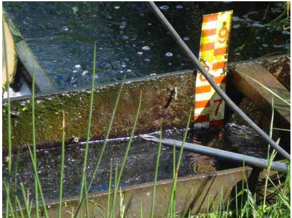
Figur 16.4.1.2 Rektangulær rende til måling af vandmængder i afløb fra plantelagune (dambrug). Vandstand registreres kontinuert med en tryktransducer (ikke vist), vandstandsbræt er til kontrol. Vandmængde i rende måles med vingeinstrument.
