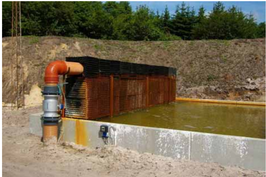
Foto 16.2.3.10 Okkeranlæg ved Ejstrupholm Dambrug, hvor indtagsvandet beluftes inden anvendelse i produktionen.
