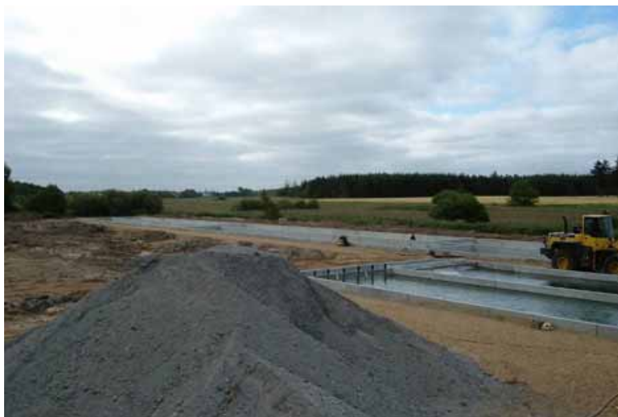
Foto 16.2.3.7 Produktionsanlægget ved Nørå Dambrug under opbygning.
