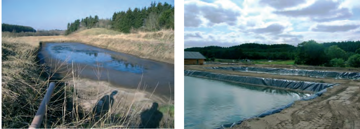
Figur 19. Fra slamkeglerne pumpes slammet til slambassiner/tanke, hvor partikulært materiale bundfældes. Billedet til venstre er fra Ejstrupholm modeldambrug og det til højre er fra Løjstrup modeldambrug (type 3). Foto: Alfred Jokumsen og Lisbeth J. Plesner.
