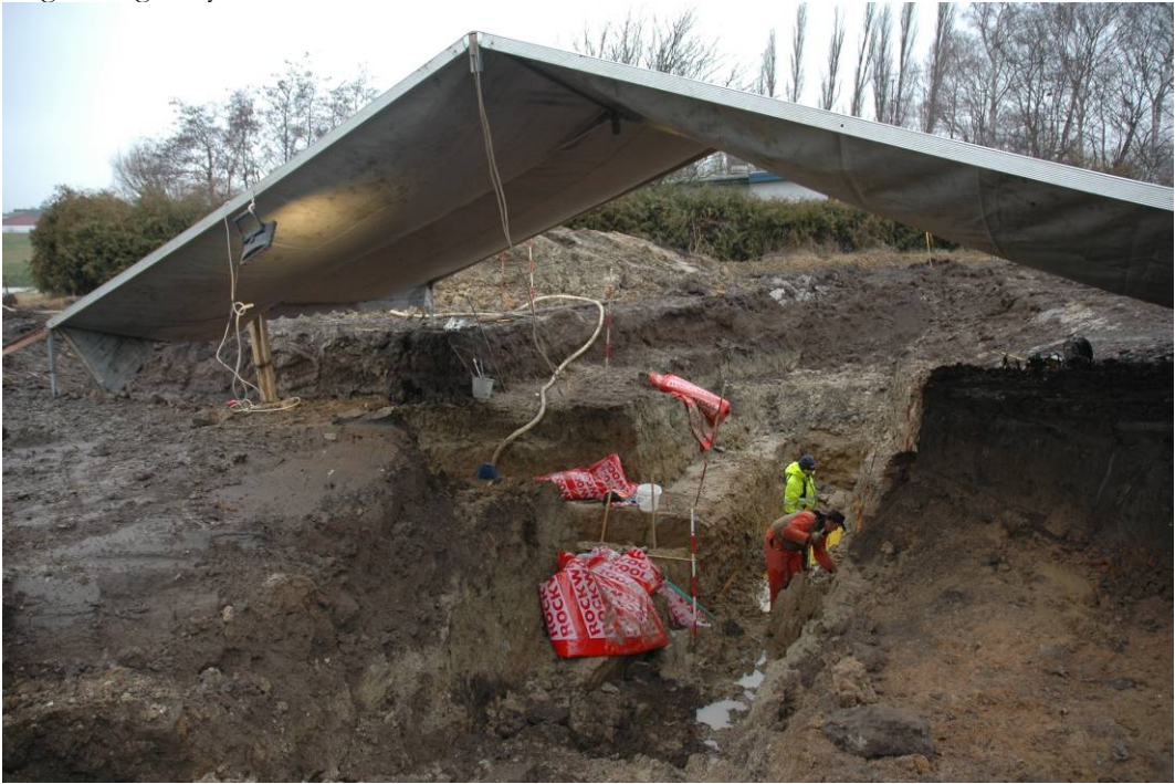
Udgravning af hydraulisk fraktur i 3 m u.t.
