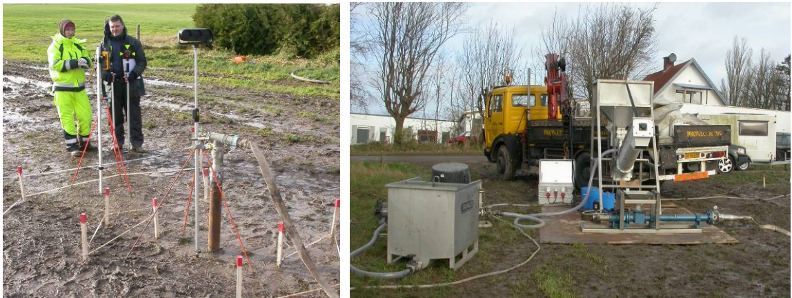
Figur 4: (v) Fraktureringsboring med monteret tryktæt system der med en slange er forbundet til blandingsanlægget. Endvidere ses målepinde til løbende måling af landhævning. (h) Blandingsanlægget. Til venstre i billedet ses beholderen hvori geleen blandes. De blå spande under anlægget indeholder borax og enzymmasse.
