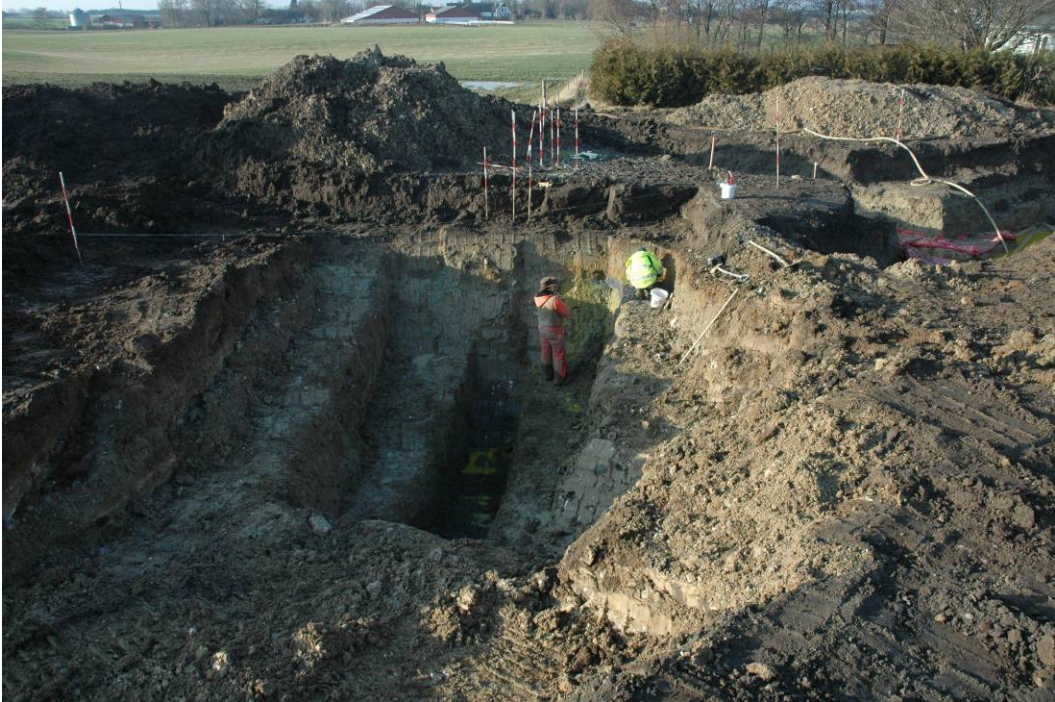
Udgravning af GeoProbe klyngeinjektionfeltet
