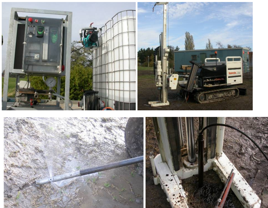
Figur 3: (øverst v) Flowmåler. (øverst h) Geoprobe benyttet til injektion. (nederst v) Injektionsspids. (nederst h) Under injektion med GeoProbe. Slangen er forbundet med blandingstanken.
