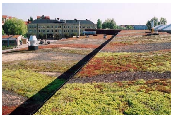
Figur 3.1. Grønne tage er eksempel på en integreret vandhåndtering i byer. Tagene reducerer og udjævner afløb efter regnvejrshændelser, renses vandet og sparer energi til såvel opvarmning som afkøling. Fra www.greenroof.se .
