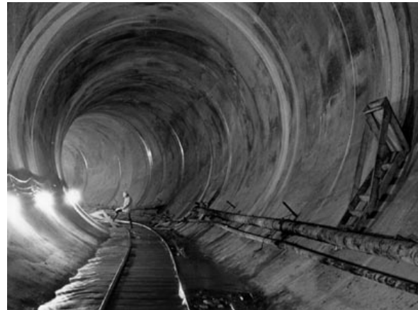
Figur 4.1. Et projekt, der ikke øger selvforsyningsgraden og derfor ikke fandt vej til bruttolisten: New York City henter vand op til 200 km fra centrum af byen. Vandet transporteres i enorme rørledninger som denne Tunnel no. 3, der konstrueres i perioden 1970-2020 75-240 m under jorden. Foto: www.nyc.gov .
