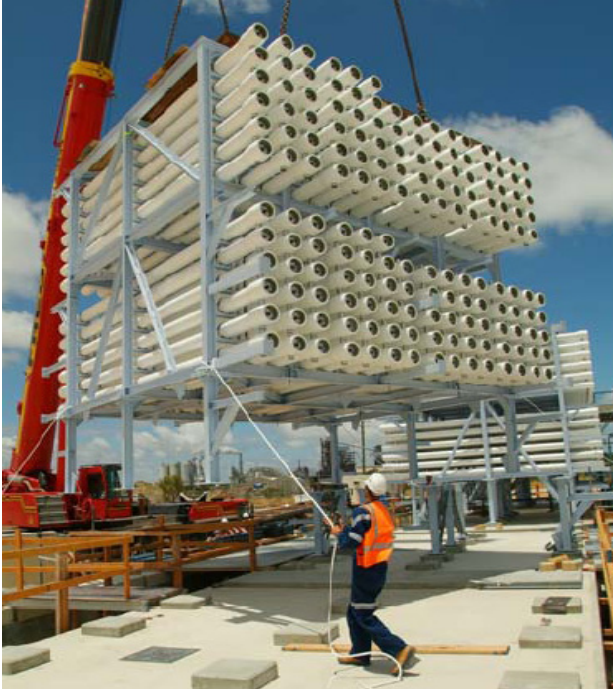
Membrananlæg installeres på Perth Desalination Plant (Foto: Water Corporation)
