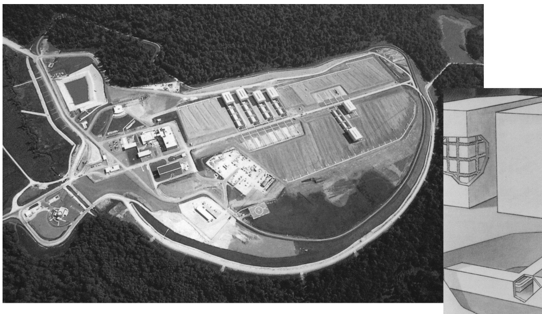
Figur 2.4. Luftfoto af det franske slutdepot Centre de l'Aube kort efter, at det blevet åbnet. Affaldsenhederne anbringes i betonceller, der ses i de fire rækker midt i billedet. Til højre er vist en tegning af en færdig celle, med omstøbte betonbeholdere samt gangsystemet nedenunder.
