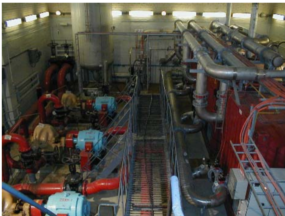
Figur 6.3. Brandbeskyttelses anlæg til Leningrad-værket. De røde containere til højre i billedet indeholder tre uafhængige, færdigmonterede systemer.
