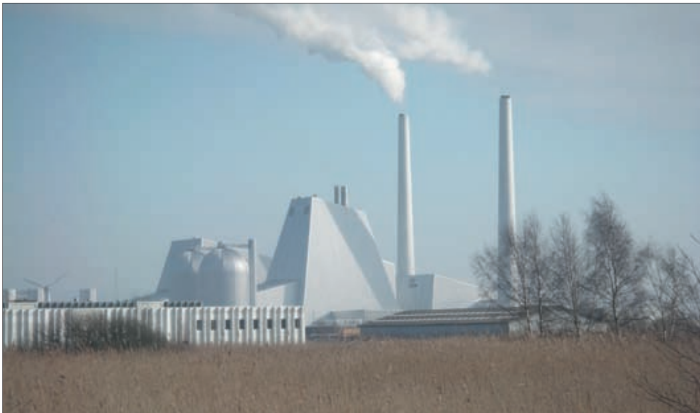
Figur 1. Avedøreværket. Røggasrensningens anlæggene inkl. afsvovlingsanlæggene befinder sig i to bygninger (ved de to store skorstene). Blok 1 er primært kulfyret, mens blok 2 benytter en blanding af naturgas, olie, halm og træpiller.
