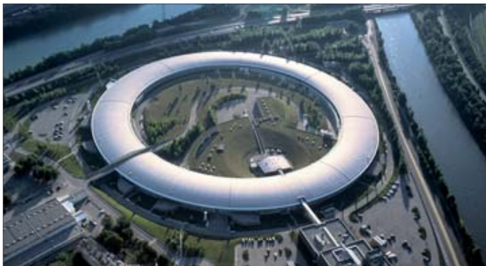
Figur 5. Fotografi af synkrotronen i Grenoble. En synkrotron er en ringformet accelerator, hvor ladede partikler, så som elektroner, kan opnå hastigheder tæt på lysets hastighed. Denne bevægelse bevirker, at der bl.a. udsendes intens røntgenstråling (Foto copyright Denis Morel).
