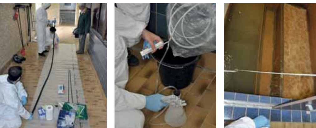
Figur 1: Desinfektion og montage af prøvetager og udtagning af vandprøver.
