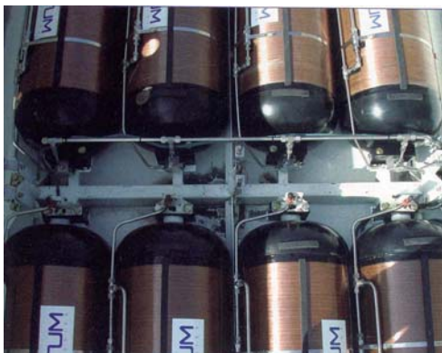
Fiberforstærkede trykbeholdere til lagring af brint ved 70 MPa [2, 3]
