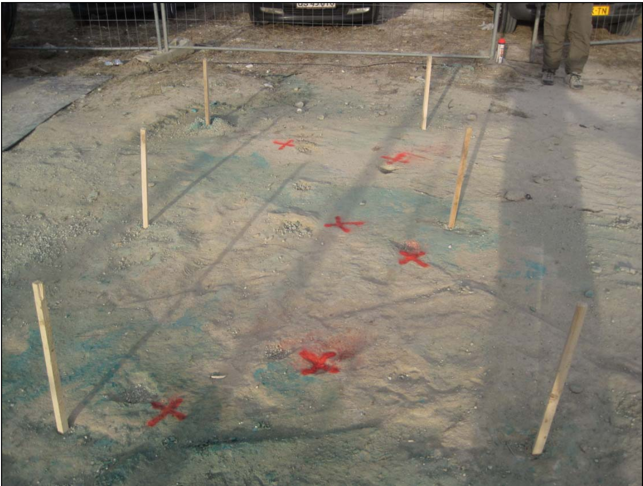
Figur 2 Foto illustration af placering af injektionspunkter (pæle) og planlagte ROST sonderinger (krydser) i injektionsfeltet
