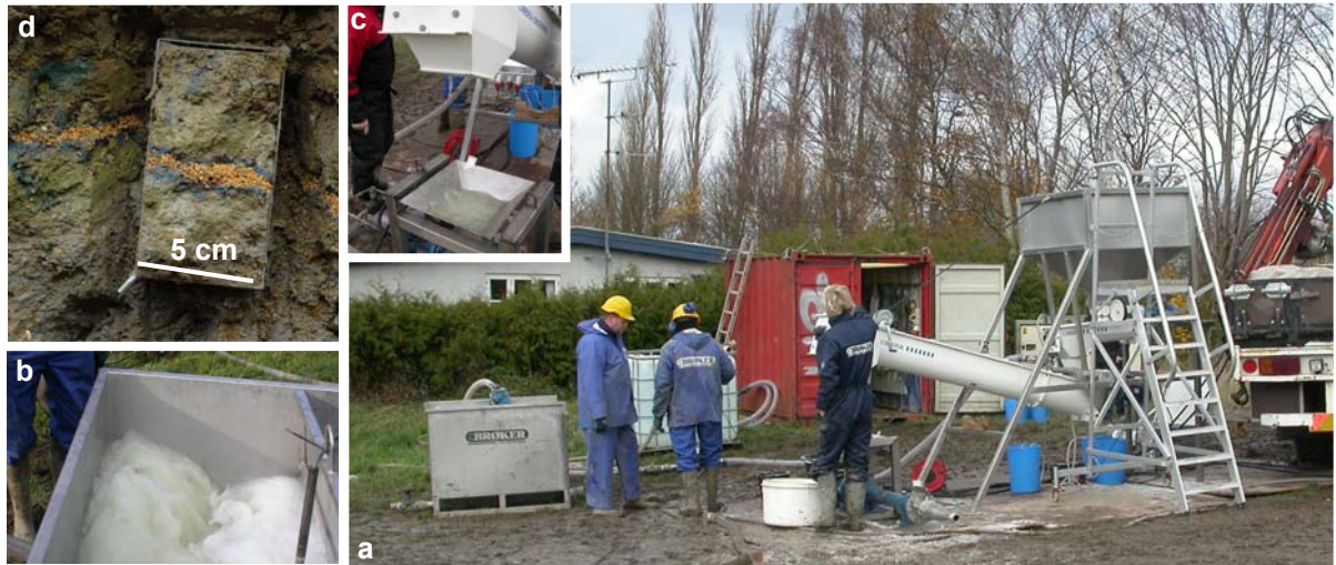
Figur 2: Hydraulisk frakturering i billeder – taget ved pilotprojekt på Vadsbyvej, Hedehusene (beskrevet i /4/ og /6/). (a) Udstyr og mandskab. (b) Guar-gel-blanding. (c) Tragt hvorfra sand-guar-blanding pumpes ned i boring. (d) Udgravet sprække dannet ved hydraulisk frakturering 3 m u.t. (gult sand – omkransende blå farve er farvestof injiceret i sprækken efterfølgende for at vurdere spredning).
