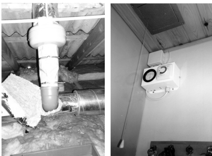
(a) Udsugningssystem på loft
