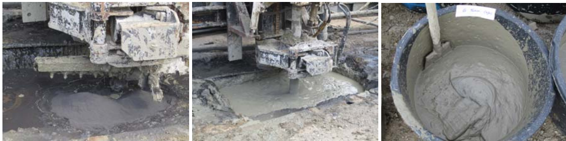
Figur 6: Soil mixing i billeder – taget ved forsøgslokalitet i Region Hovedstaden. (v) Mixerhoved roteres ned i jorden. (m) Bassin udgravet ved terræn for at begrænse slurry-overløb ved overfladen. (h) Relativt homogen blanding af jord, vand og bentonit opnået ved soil mixing.
