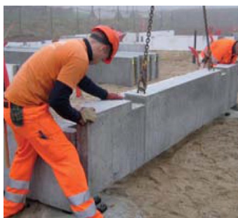
BoKlok i Måløv. Præfabrikerede kantfundamentsbjælker på punktfundamenter, isolering og installationer under volumenelementerne. Foto: BoKlok
