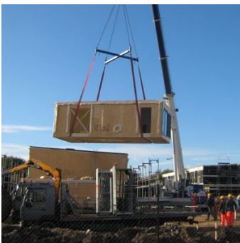
De præfabrikerede volumenelementer bliver hejst på plads.
