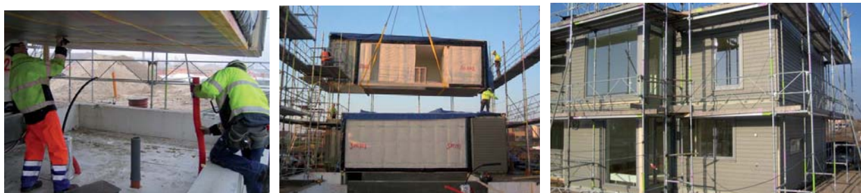
Figur 34, 35, 36 Montering af BoKlok rækkehusene i Måløv
