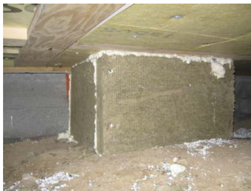
Figur 85 Isolering omkring rørforbindelser
