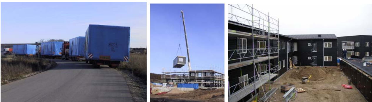
Figur 31, 32, 33 Volumenmoduler transporteres, hejses på plads og samles
