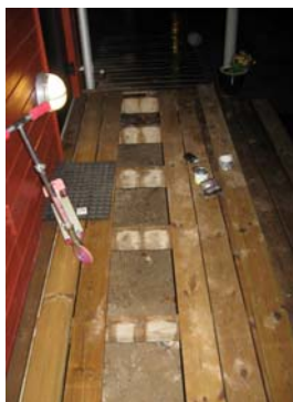
Figur 92 Terrassebrædder fungerer som ventilationsrist
