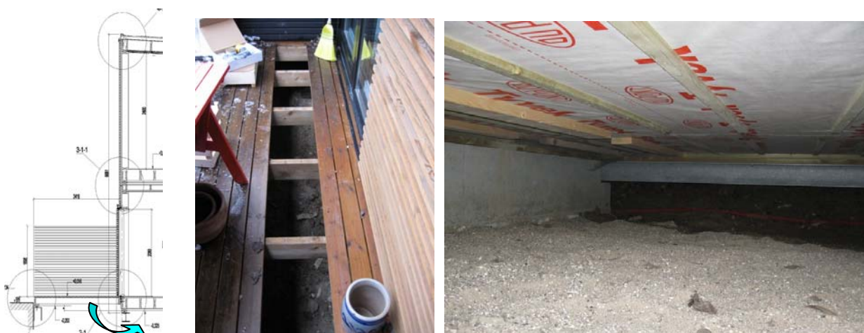
Figur 10, 11 Vildrose 1 og 2: Snit i Facade Terrassebrædder virker som ventilationsrist fotos viser rist med optagne brædder og ventileret krybekælder.
