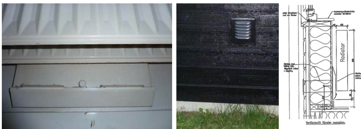
Figur 69, 70, 71 Ventil med tvangsventilation bag radiator Boklok Hillerød
