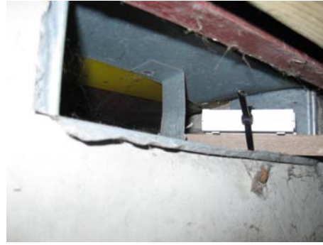
Figur 95 HOBO føres ind under kassetten
