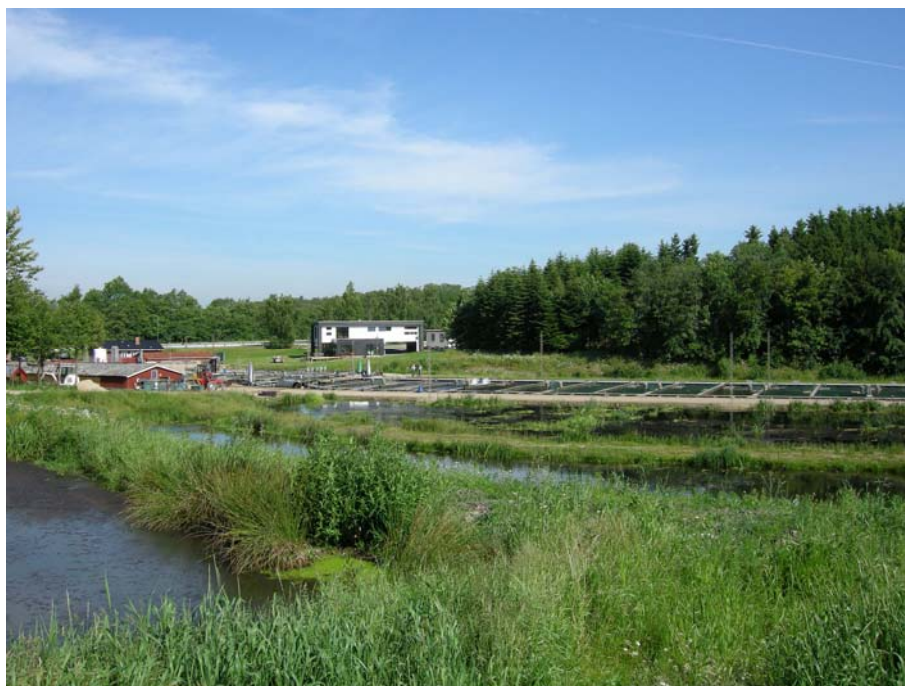
Foto 8. Brejnholm Dambrug og en del af plantelagunerne ved dambruget. Foto: Lars M. Svendsen.
