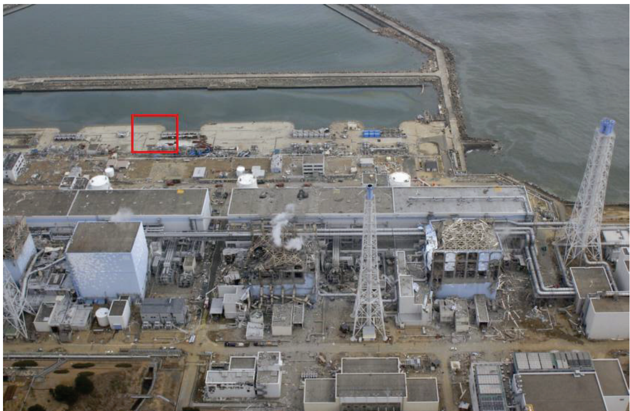
Figur 3.2. Øverst: De seks enheder på Fukushima Daiichi værket inden ulykken. Nederst: Enhed 1-4 på værket. Reaktorbygningerne på enhed 1 (delvist skjult), 3 og 4 er stærkt beskadigede af brinteksplosioner, mens reaktorbygningen på enhed 2 fremstår intakt. Den røde firkant markerer en brønd med stærkt radioaktivt vand.
