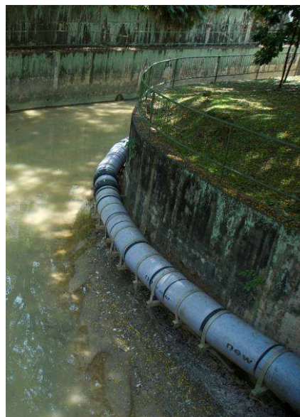
Figur 3.7. Distribution af NEWater i betonrør. Her i forbindelse med afløbskanal.
