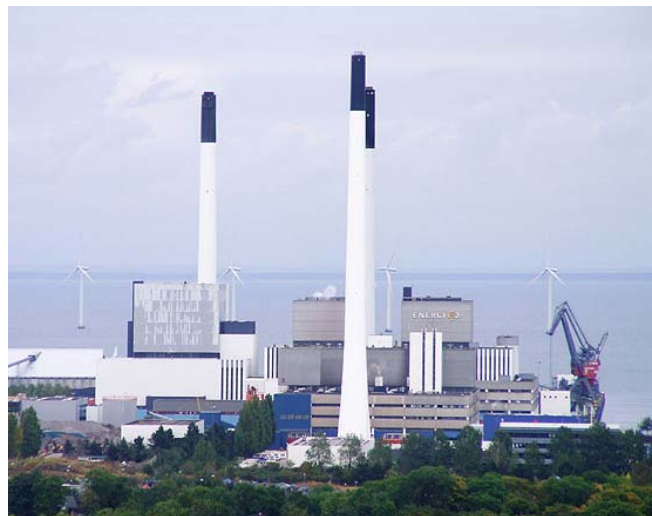
Figur 10 På Amagerværket har man erstattet 90% af vandforbruget med andre kvaliteter vand end forsyningsvand
