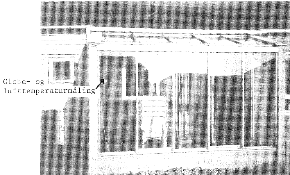
Figur 4.3.15. Glastilbygningen set fra syd med angivelse af hvor globe- og lufttemperaturen måles.
