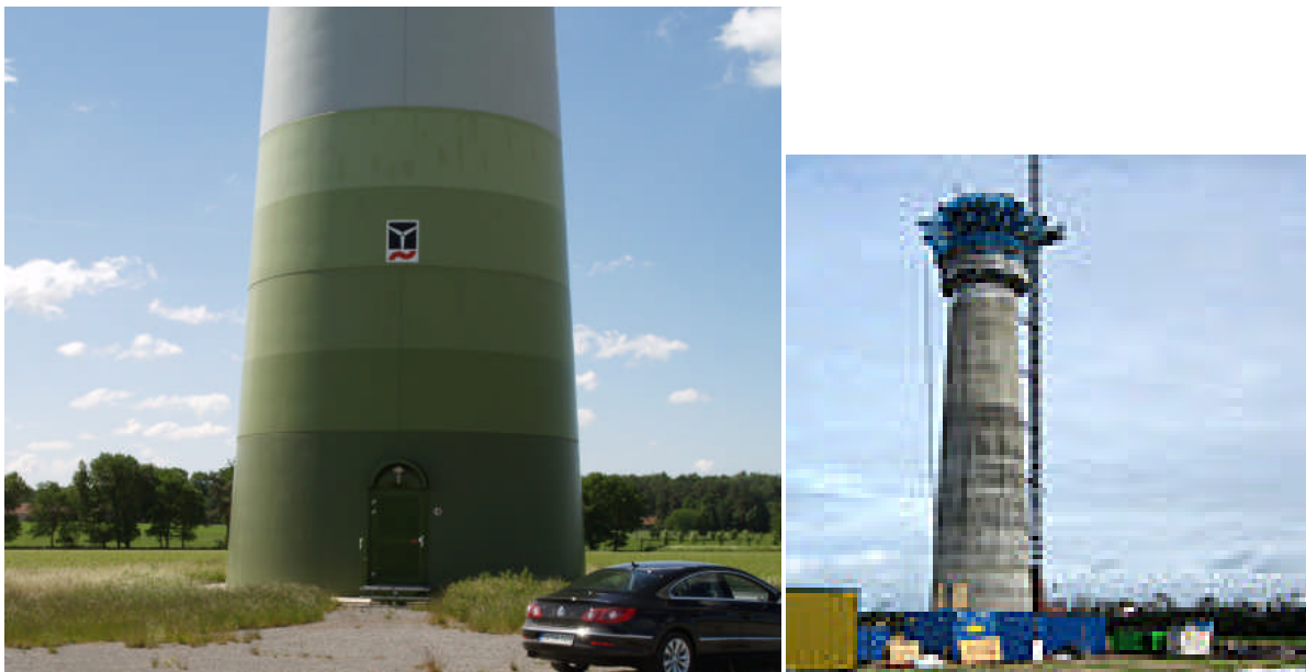
Figur 33 Bundsektion af Enercon tårn, som er opbygget af beton skaller der kan køres til placeringen i normal lastvognstransport og herefter samles på stedet. Til højre fra COWI hjemmeside billede af støbning prototype af Siemens beton tårn syd for Lemvig. Her er tale om en glideforskalingsmetode som kendes fra mange andre sammenhænge – og i øvrigt blev anvendt på Tvind møllen tilbage i 1978.
