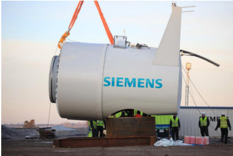
Figur 32 Siemens har taget det gearløse koncept op. Her ses nacellen for 3 MW (101m rotor) prototype, der rejses af Uhre vindmøllelaug nær Siemens hovedsæde i Brande, ultimo 2009. Foto er fra http://www.uhrevind.dk , hvor byggeriet kan følges uge for uge.
