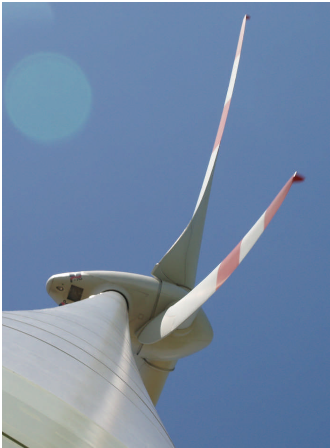
Figur 31 Enercom mølle, hvor man kan se dels winglets, dels hvorledes roddelen af vingen er ført helt ind navet med aerodynamisk profil.
