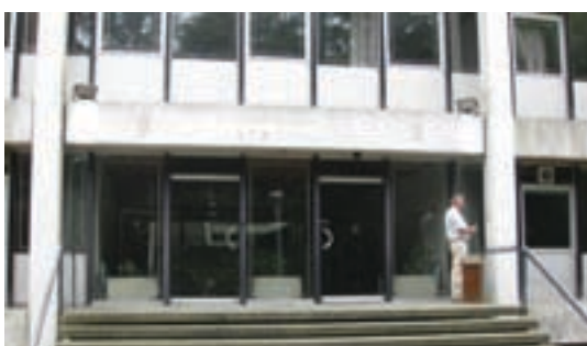
Forsvarskommandoens tidligere domicil, hvor planen er en total renovering til erhverv
