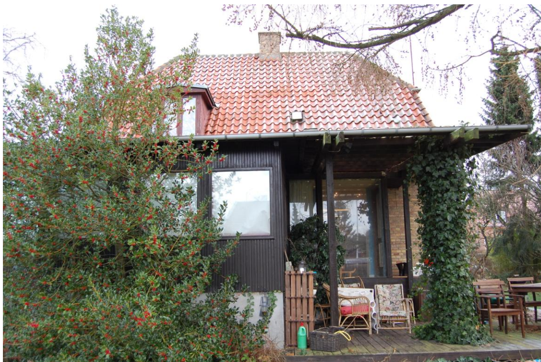
Figur 7. Facade mod vest med tilbygning i lette konstruktioner sammenbygget med det oprindelige hus via en mellemgang, samt overdækket terrasse.
