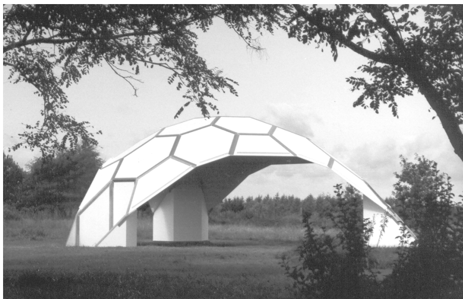
Figur 23. Fuldskalamodel på SBi i Hørsholm. Eksempel på positivt krum ikke-successivt opbygget skiveskal, baseret på system D, med fri rande der ikke er udkragede. Stringersystem og skivesystem fremgår af figur 24. Understøtningerne udgør i sig selv tre nul-krumme skiveskaller.
