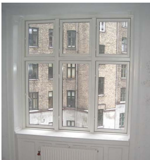
Figur 13. Vindue 3 set indefra.
