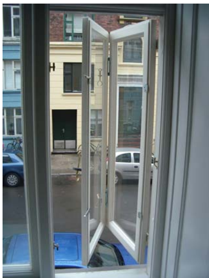
Figur 12. De koblede rammer kan åbnes for at give adgang til at pudse glasset i hulrummet.
