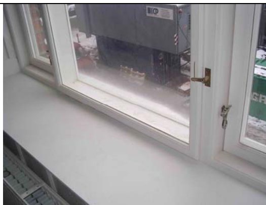
Figur 9. Vindue 2. Forsatsvindue i midterfeltet.
