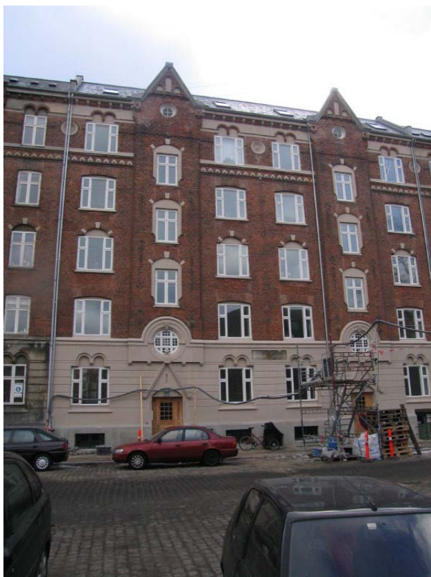
Figur 10. Ejendommen i Florsgade på Nørrebro i København hvor vindue 2 og 3 er monteret.
