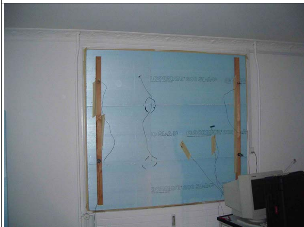
Figur 16. 50 mm Polystyrenplade monteret på den indvendige side af vindueshullet.
