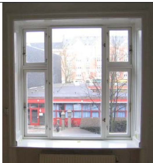
Figur 6. Vindue 2 set indefra.
