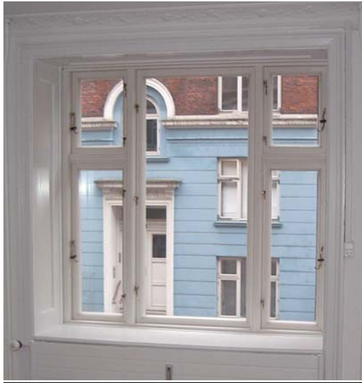
Figur 3. Vindue 1 set indefra.
