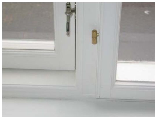
Figur 8. Vindue 2. Koblet ramme i sidefelt til venstre. Forsatsvindue i midterfeltet.
