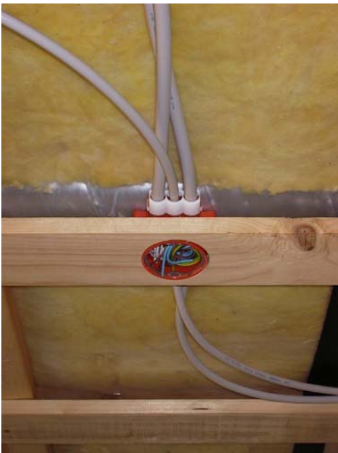
Figur 1. Loftkonstruktion under opførelse. Billedet til venstre viser at dampspærren er placeret beskyttet, idet den er trukket tykkelsen af to forskallingslag ind i konstruktionen. Billede til højre viser rørkrave og tape der sikre tætheden hvor dampspærren gennembrydes og ved plastfoliesamlinger.
