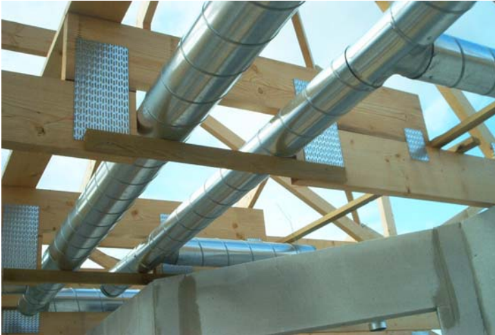
Figur 2. Spærløsning anvendt i forsøgshuset – muliggøre fremføring af ventilationskanaler i den nederste del af loftkonstruktionen.
