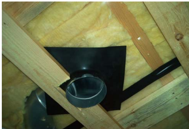
Figur 1. Loftkonstruktion under opførelse. Billedet til venstre viser at dampspærren er placeret beskyttet, idet den er trukket tykkelsen af to forskallingslag ind i konstruktionen. Billede til højre viser rørkrave og tape der sikre tætheden hvor dampspærren gennembrydes og ved plastfoliesamlinger.
