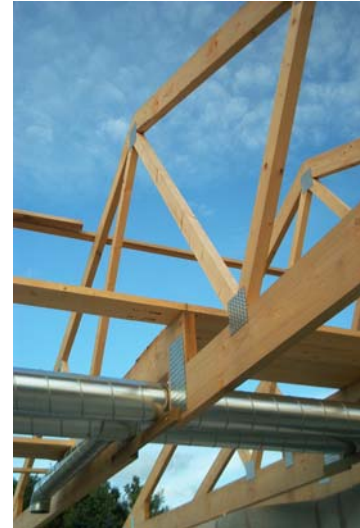
Figur 2. Spærløsning anvendt i forsøgshuset – muliggøre fremføring af ventilationskanaler i den nederste del af loftkonstruktionen.
