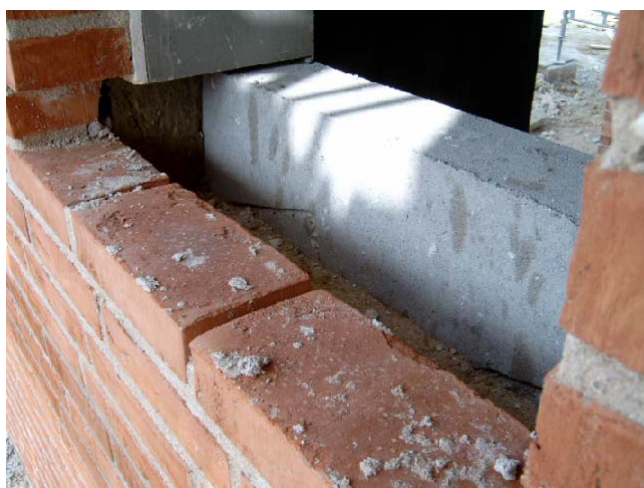
Figur 8. Vindueshul med tilsætninger ved sidefals monteret
